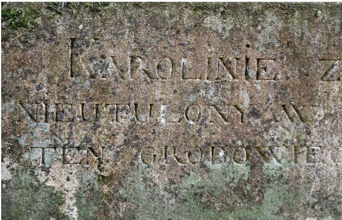
fot. 9. Inskrypcja. Widoczne zacierające się krawędzie liter, przebarwienia kamienia i intensywny porost mikroorganizmów.
