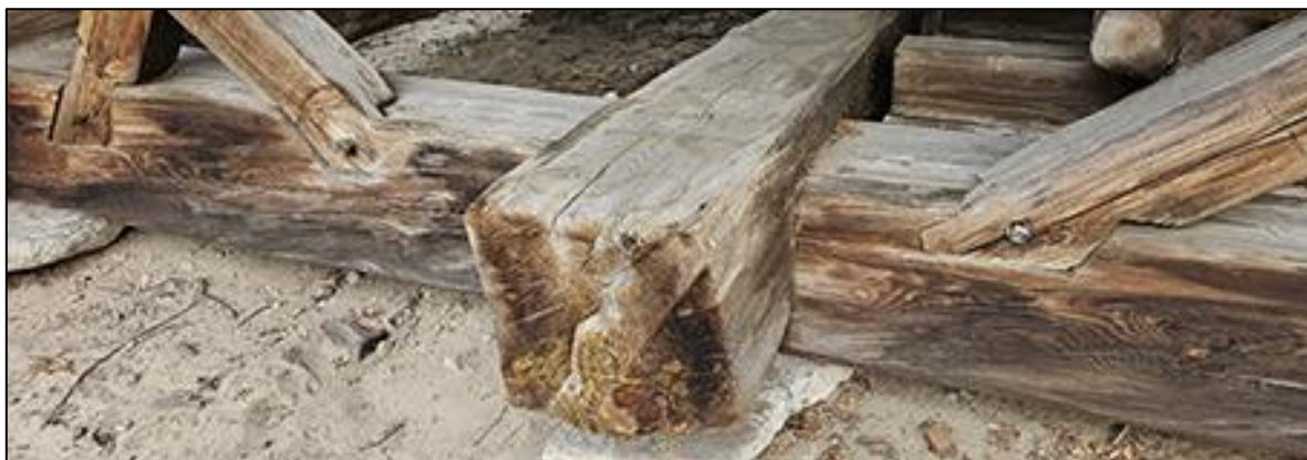
Fot. 24. Przebarwione, ale w dobrej kondycji technicznej, belki podwalinowe oparte na kamieniach.
