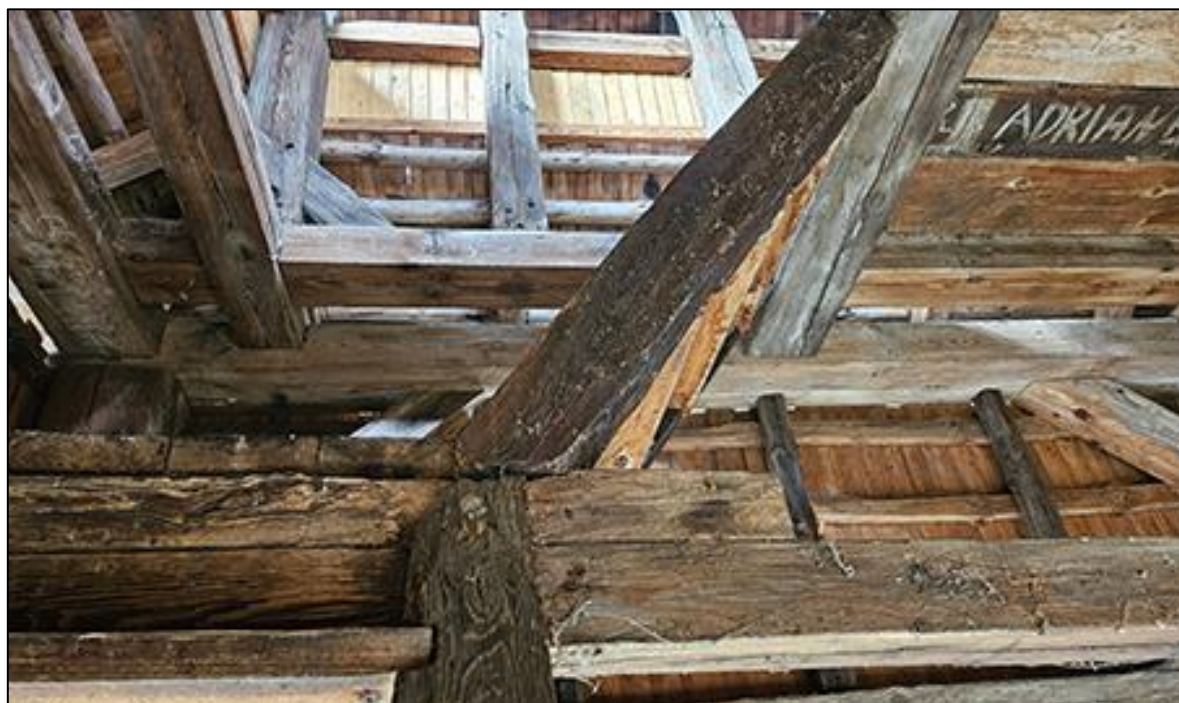
Fot. 15. Oryginalne i wtórne elementy konstrukcyjne.
