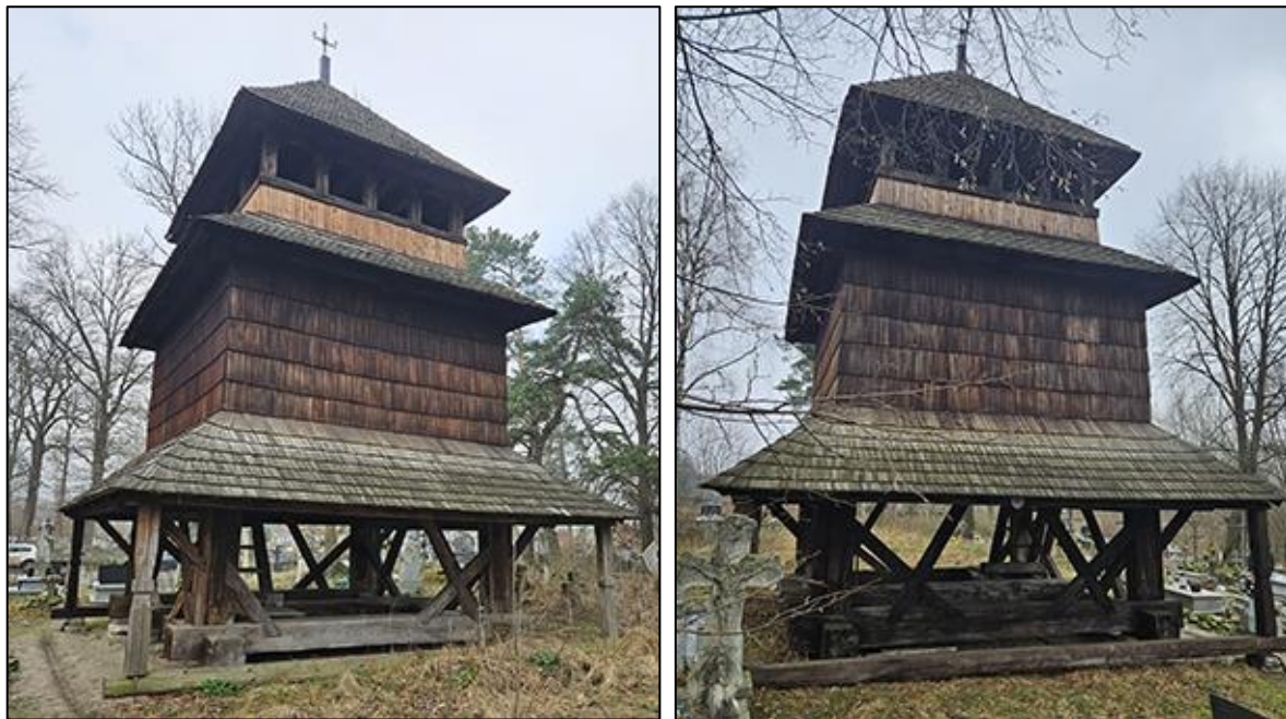
Fot. 7. Fot. 8. Dzwonnica z Teniatysk – widok obecny. Widoczne nowe, odmienne kolorystycznie poszycie drugiej kondygnacji oraz intensywna biodeterioracja pokrycia dachów.
