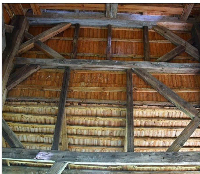
Fot. 5. Fot. 6. Cmentarz_greckokatolicki_1221317_Fotopolska-Eu; Dzwonnica_1221318_Fotopolska-Eu. Dzwonnica po przeniesieniu na cmentarz w Lubyczy; stan w 2018 r. Widoczne uszkodzenia i ubytki poszycia.
